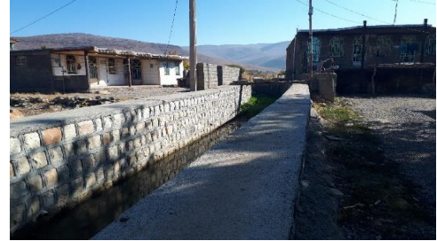
شکل (۲): کانال سنگ و ملاتی موجود
