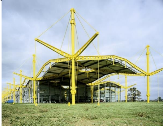
تصویر ۷: مرکز توزیع رنو، سويندن، ۱۹۸۳، به مثابه یک واحد صنعتی که با سیستم سازه‌ای کابلی طراحی شده است. مأخذ: (fosterandpartners, 2026).
